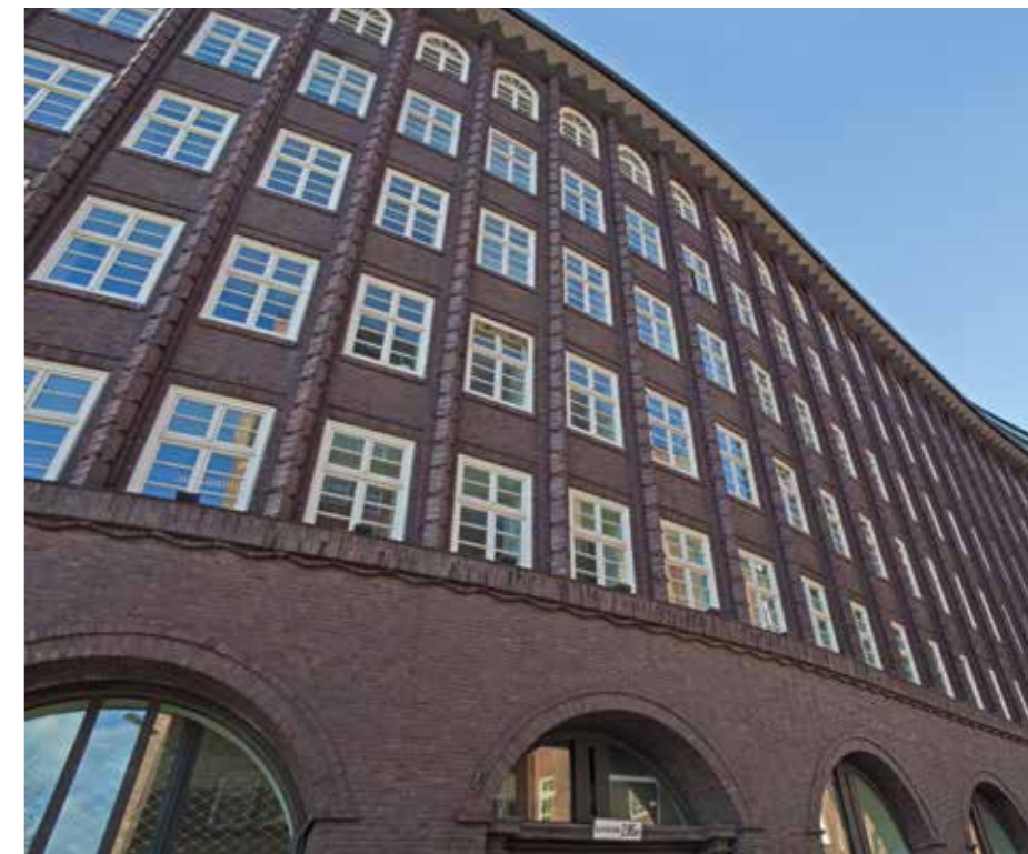
↑ Das Chilehaus im Kontorhausviertel war beispielgebend für den Backsteinexpressionismus der 1920er-Jahre.
