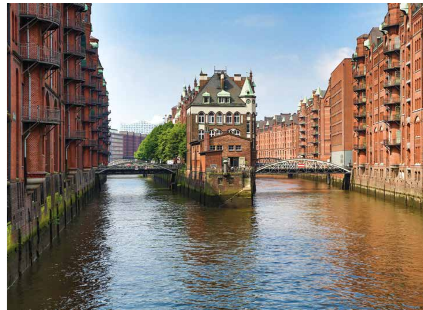
↑ Rund 26 Hektar zwischen Baumwall und Oberhafen: die Hamburger Speicherstadt
