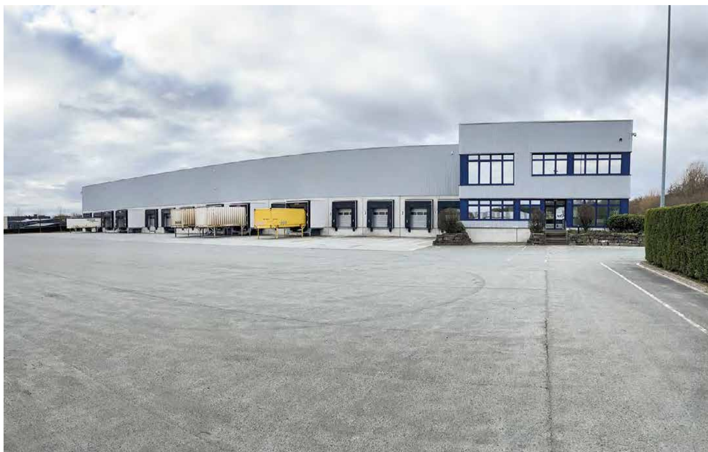
↑ Der neue Standort der Borchers NordWest Warehousing Solutions GmbH in Werne.
